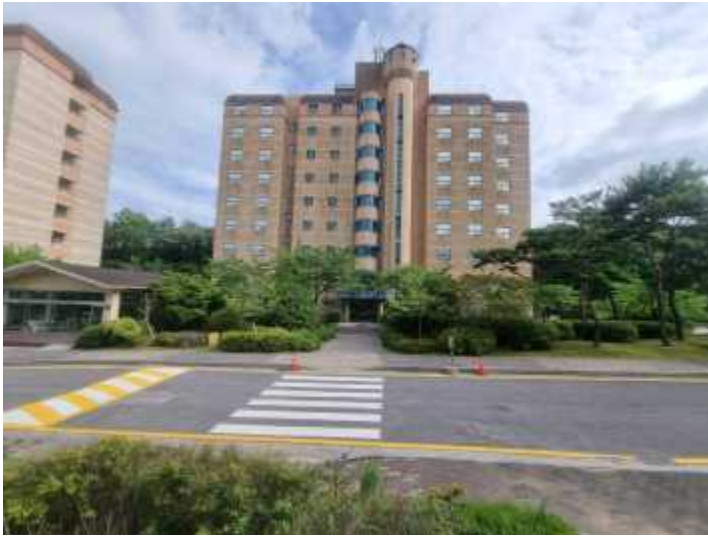
송강학숙 1호관 전면 현황
